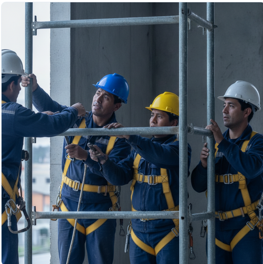
Trabajadores realizando el montaje de un andamio modular, con énfasis en las conexiones seguras de los componentes y el uso de equipo de protección personal.
